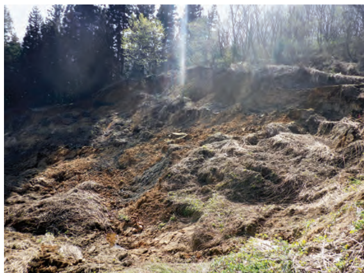
地すべり崩壊 (R6年1月：長岡市神妙野地区)
